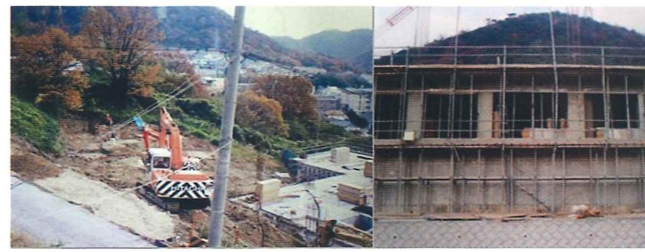
工事の様子 (㊦法面工事 ㊦地階部分)
