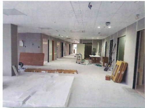
各種設備工事が順調に進んでいます。(12月18日)
