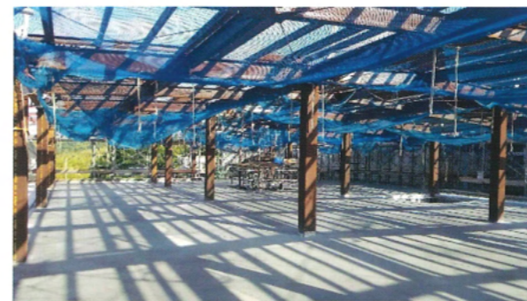
各階の床のコンクリート工事は表面均しが大変です。(9月7日)
