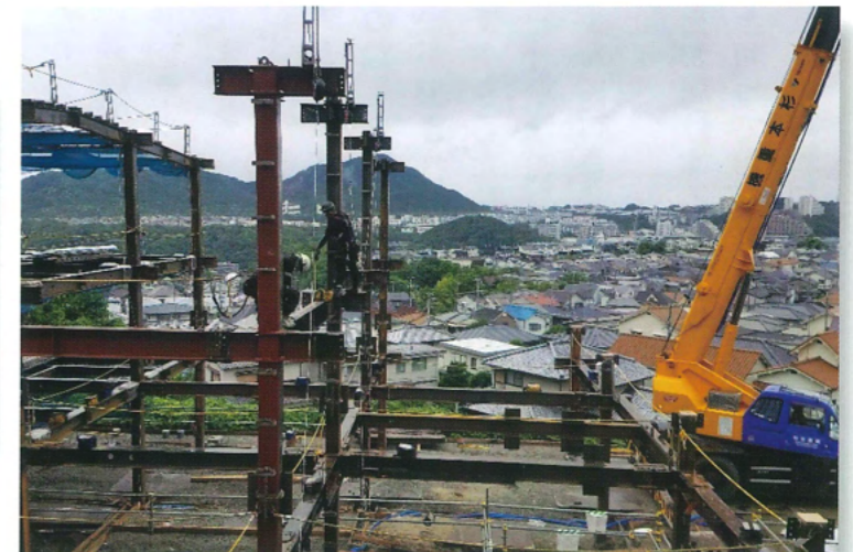
梅雨の天気を気にしながら、鉄骨の工が進みます。(7月10日)
