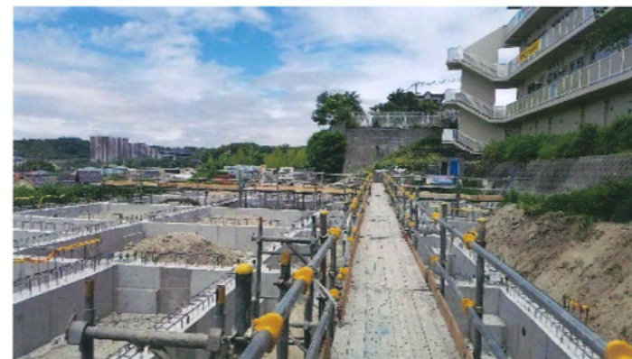
地中梁の工事が終わればよいよ地上部の工事です。(6月10日)
