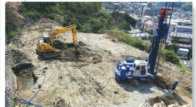
地盤改良工事が進んでいます。(令和2年4月15日)
